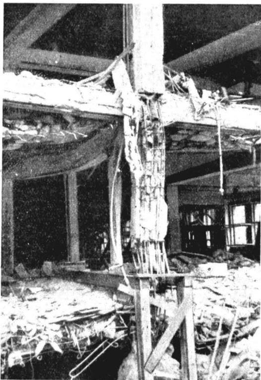
Bild 4. Frontstütze in Stampfbeton. Gerippe zerschlagen, anschließend Decke erst angehoben, dann durchgesackt. Schubrisse am Querträger (über den Holzunterstützungen von der Stütze nach innen fallend).
