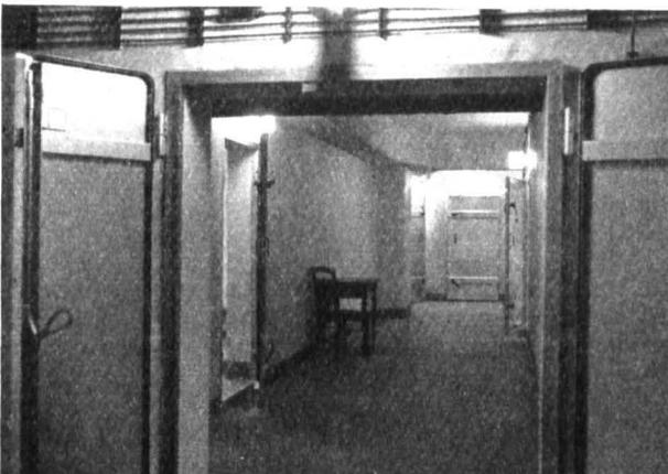
Bild 5. Blick in eine innere Gasschleuse, von der vier LS-Räume abgehen.
