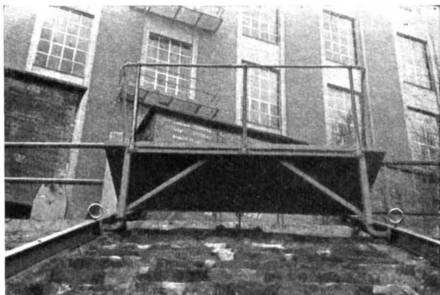
Bild 2. Die keilförmige Konstruktion des Schlittens. Vor den Rädern sind als zusätzliche Sicherung gegen ein weiteres Abgleiten des Schlittens Bolzen in die U-Schienen eingesetzt.
