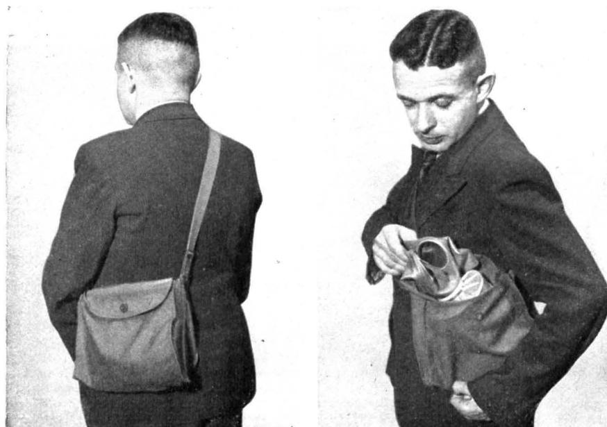
Bild 1 (links). Die Tragtasche wird mittels verstellbaren Tragbandes umgehängt. Ein überlappter Knopfverschluß soll Staub und Feuchtigkeit fernhalten. Am rechten Ende der Tragtasche erkennt man den in den Maskenkörper eingeschraubten Filtereinsatz, der dem einen Ende der Tragtasche ein kreisförmiges Aussehen verleiht. Die Tragtasche ist an dieser Seite auch entsprechend kreisförmig ausgearbeitet. Die Volksgasmaske wird in der Tragtasche liegend untergebracht.
