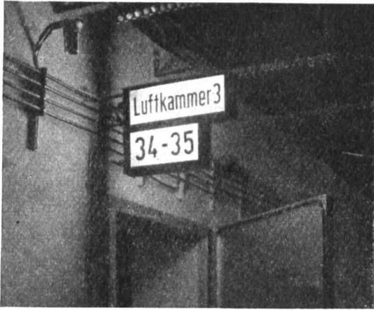
Bild 3 (oben). Kennlichmachung einer der vier Luftkammern und der LS-Räume 34—35 (die Schaltung der Belüftungsanlage erfolgt zentral entweder von der Befehls- oder von der Ausweichstelle).
