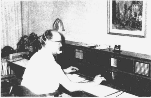
Bild 2 Bedienungspult einer modernen Fernsprech-Nebenstellenanlage (schwer ersetzbar)
