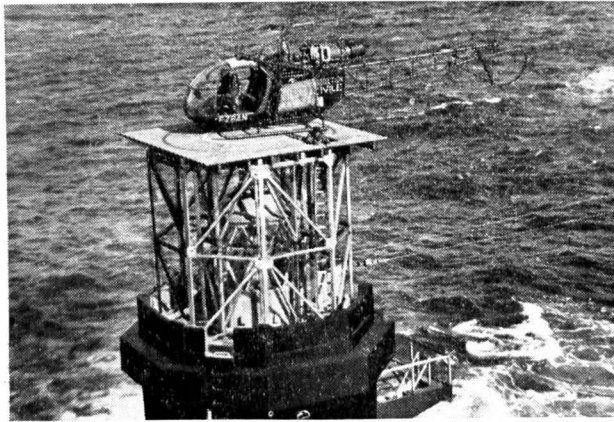
Leuchttürme an der französischen Küste wie dieser von Nividic bei Ouessant, die erfahrungsgemäß häufig für Wochen mit Booten un- erreichbar sind, wurden mit Landeplattformen für Hubschrauber ver- sehen. Der Nachschub und die Ablösung kommen durch die Luft. Für kranke Leuchtturmwärter ist das eine Frage auf Leben oder Tod.
